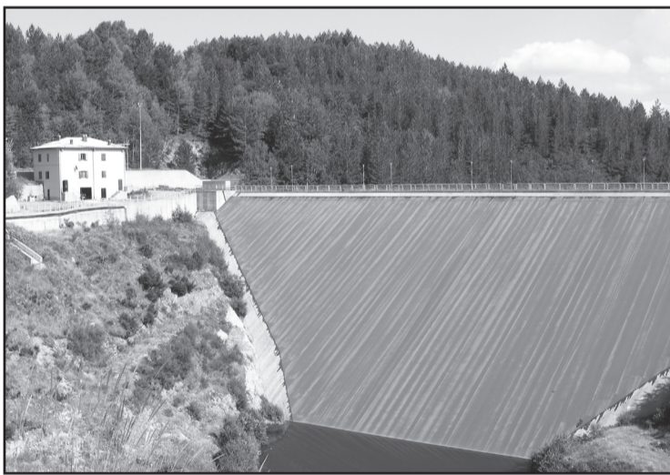
Diga di Redisole
