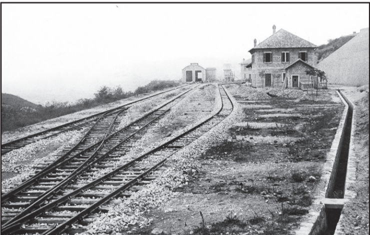
Stazione Ferroviaria delle Calabro-Lucane
