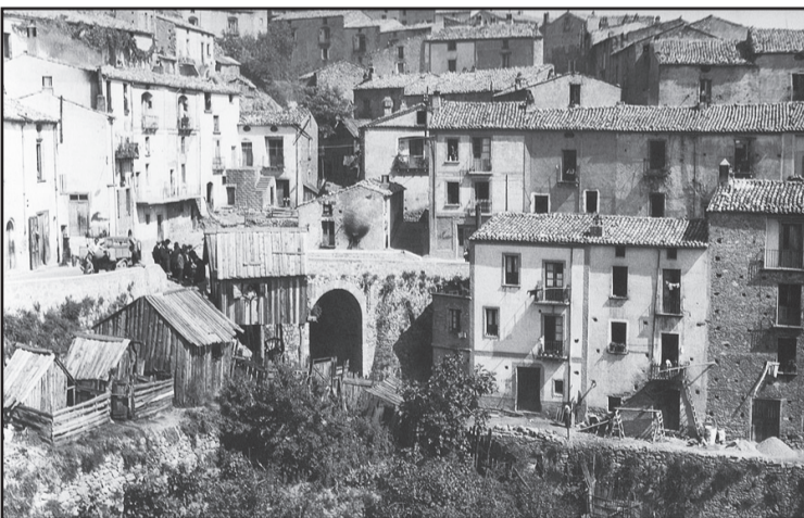
Via Roma (Ponte Costa)
